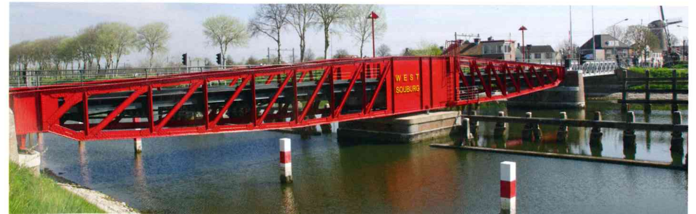
Het totaalgewicht van de gerenoveerde draaibrug (met een composietbrugdek) in Souburg is significant lager dan de oorspronkelijke uitvoering; aanzienlijk kortere openingstijden van de brug zijn het gevolg. In combinatie met het geringe onderhoud levert dit forse besparingen op.
