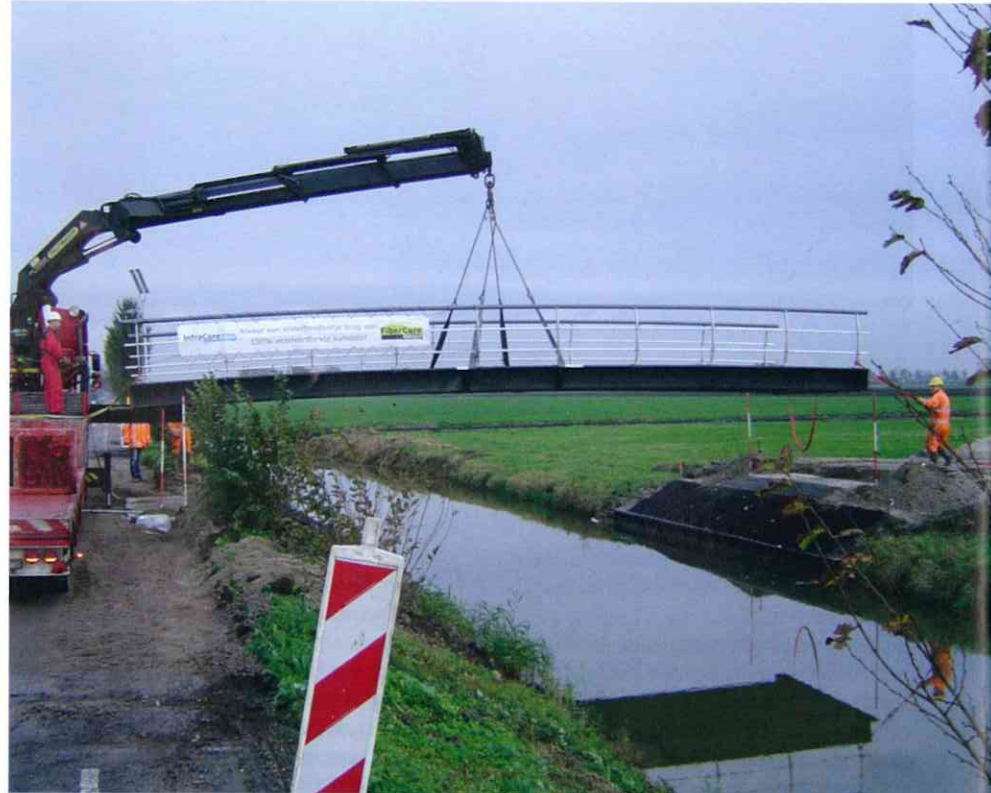
Doordat montage van de duurzame brug direct van de auto kan plaatsvinden, vaak gecombineerd met een fundatie op staal, wordt de inzet van montage- en heikranen tot een minimum beperkt.
