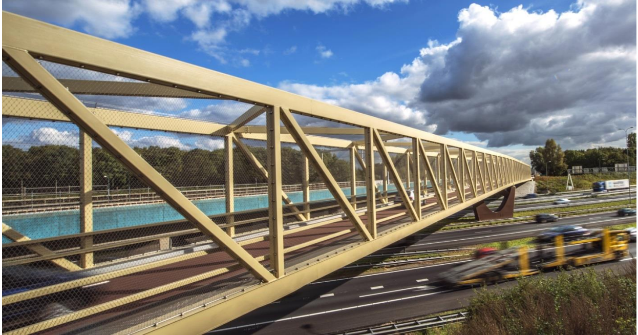
Figuur 71: Fiets/verkeersbrug over A27, staal met composiet dek (bron: Fibercore Europe). Standaarden en richtlijnen helpen om een kunstwerk op een dergelijk druk knooppunt optimaal en veilig te kunnen realiseren. De uitdaging hierbij is ze ook toepasbaar te maken op dergelijke ‘hybride’ constructies met innovatieve materialen en verbindingen.
